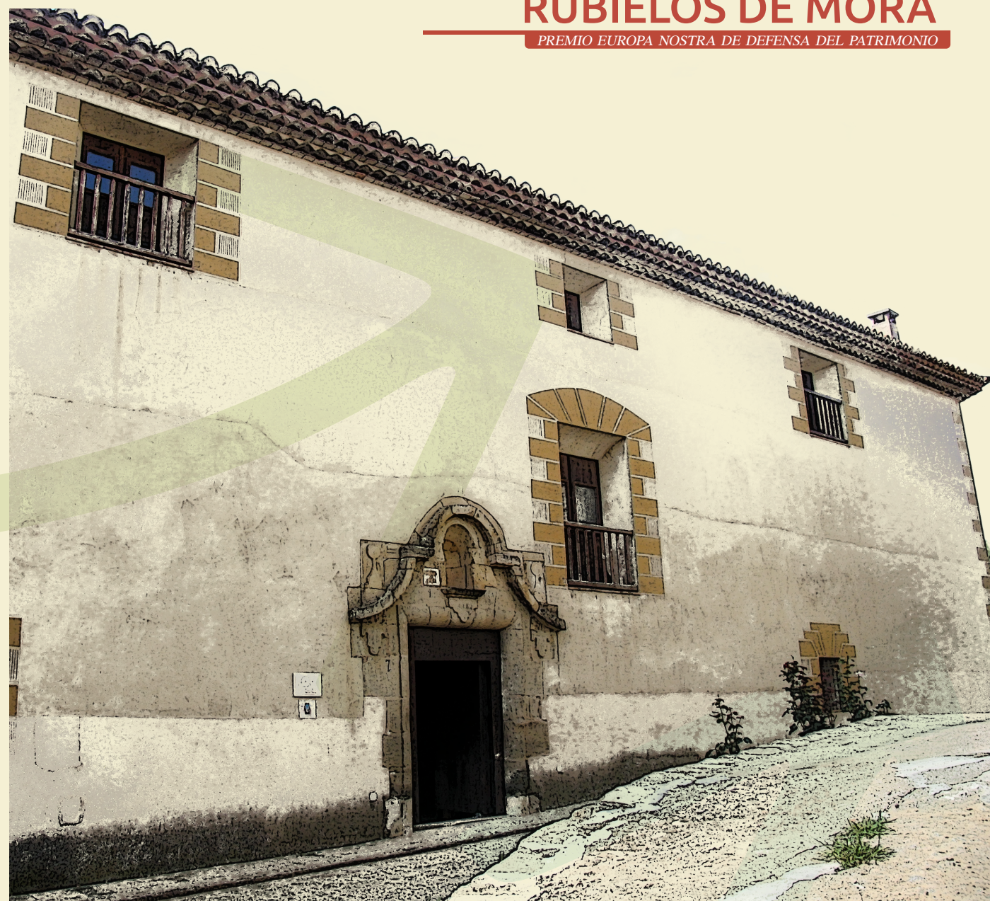
Vista exterior del edificio
