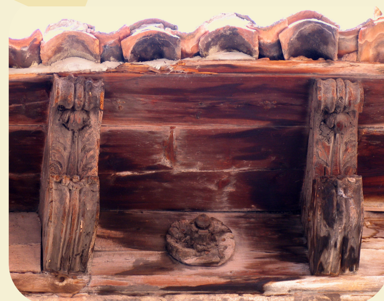
Detalle del alero de madera.
